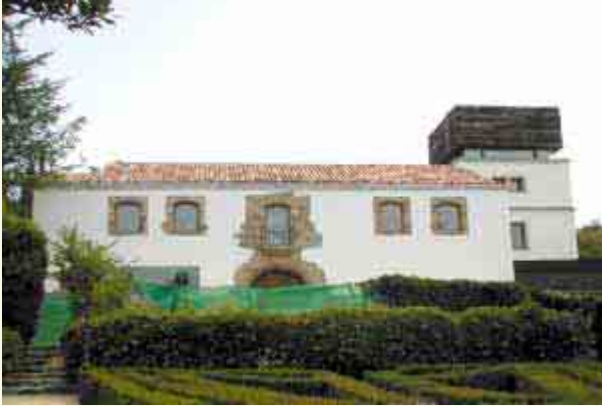
EN LA TORRE DEL CENTRO CULTURAL DE PEÑALBA, SE INSTALARÁ LA FUTURA HEMEROTECA.
