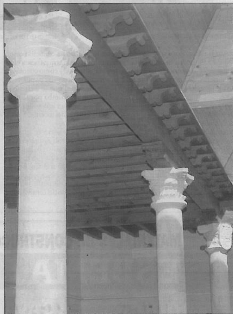
Un detalle de los capiteles de las columnas.
